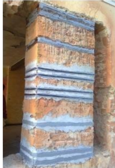
Yatay karbon lifli polimer şeritler ile güçlendirilmiş duvar
