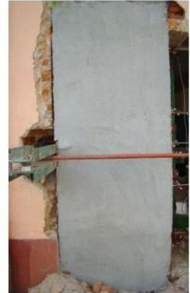
Tekstil hasır donatılı harç ile güçlendirilmiş duvar
